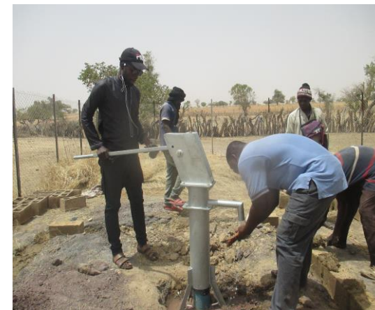
Réalisation d'une pompe à motricité humaine dans le village de Torodo à Dianguirdé en juillet 2020
