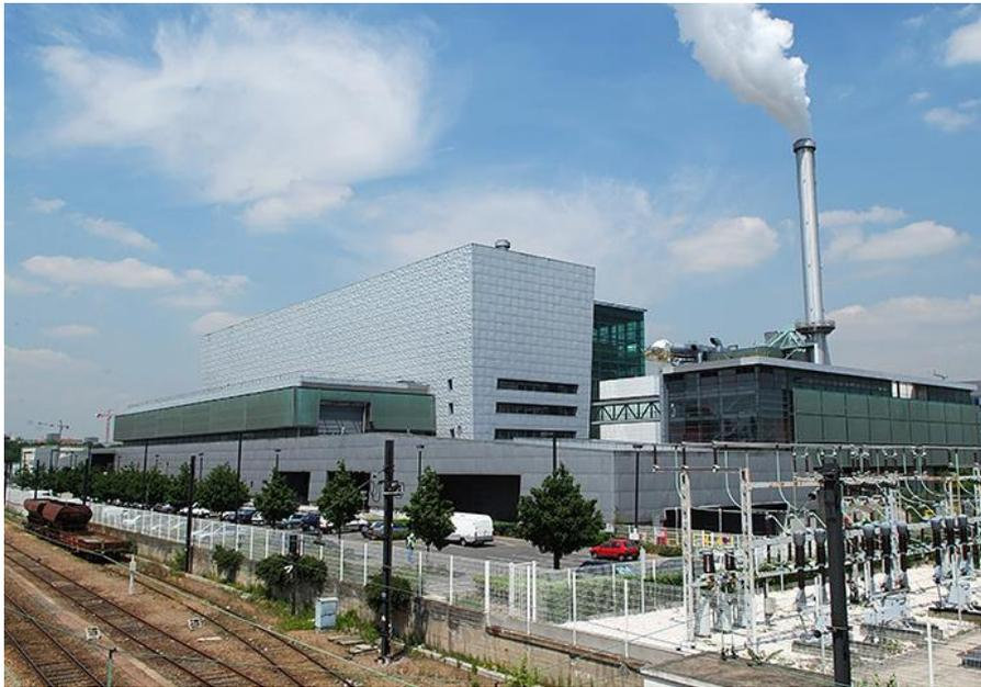
La chaleur générée par la combustion des déchets permet de produire de la vapeur, pour alimenter les réseaux de chaleur de la CPCU, et de l'électricité, utilisée pour le fonctionnement du centre et dont le surplus est vendu à EDF.
